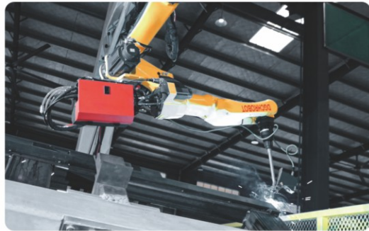
机器人自动焊接 Robotic automatic welding
