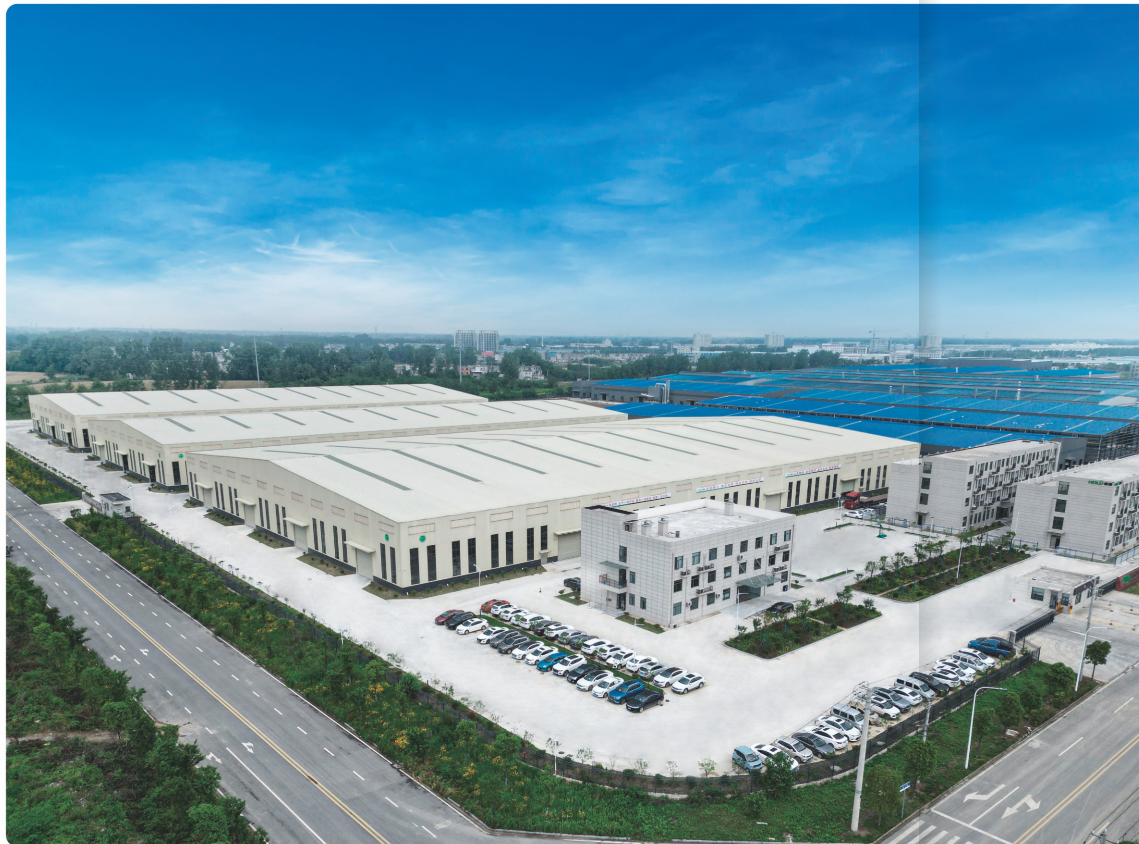
HID 湖北基地(一期) Hubei production base
